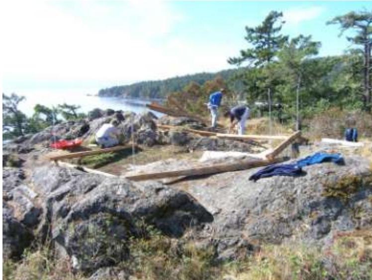
Figure 4. Construction de la clôture autour de la mare printanière.
